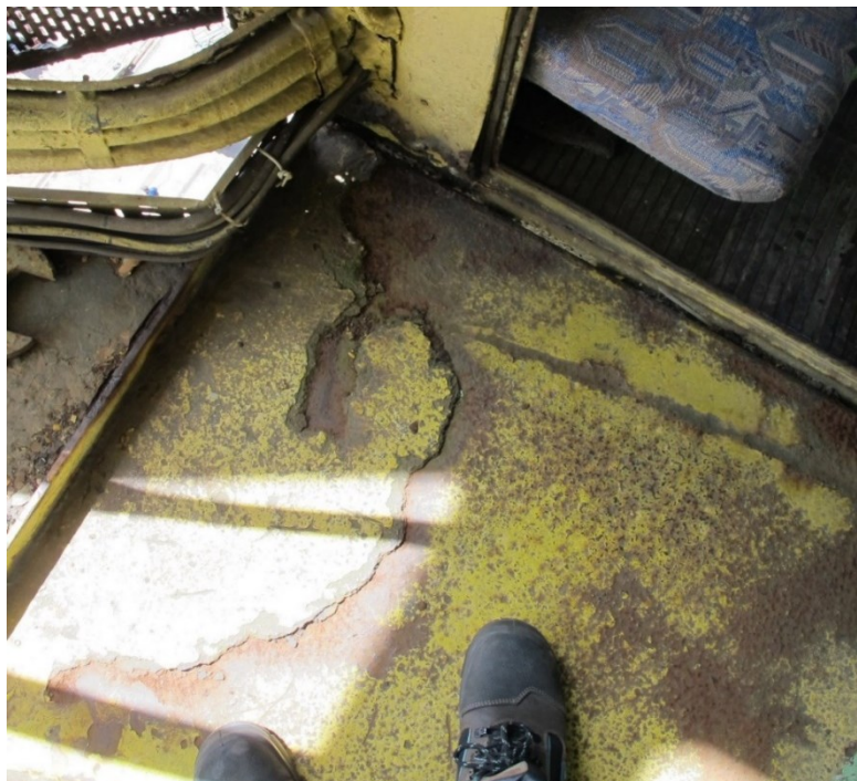
Rysunek 4. Korozja blach podestu suwnicy w obrębie dojścia do kabiny operatora.
