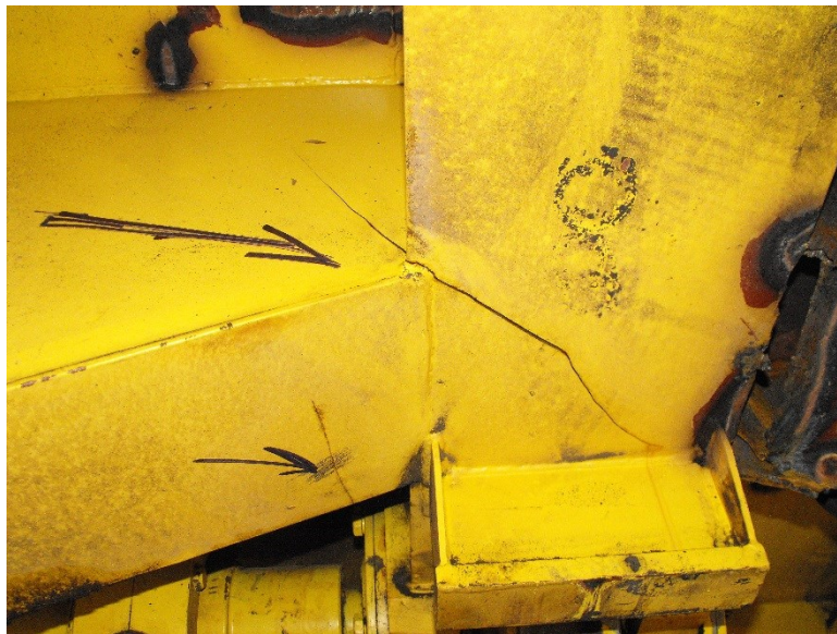
Rysunek 10. Pęknięcie ramy nośnej wciągarki suwnicy.
